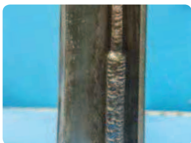
Многопроходная сварка в вертикальном положении
